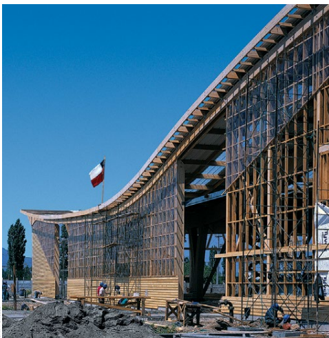
l'edificio in costruzione / the edifice during construction
