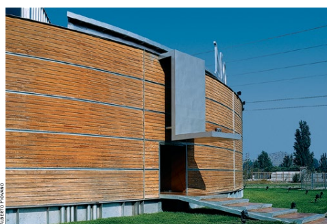
la pensilina e la scala d'ingresso / the awning and the entrance stair
