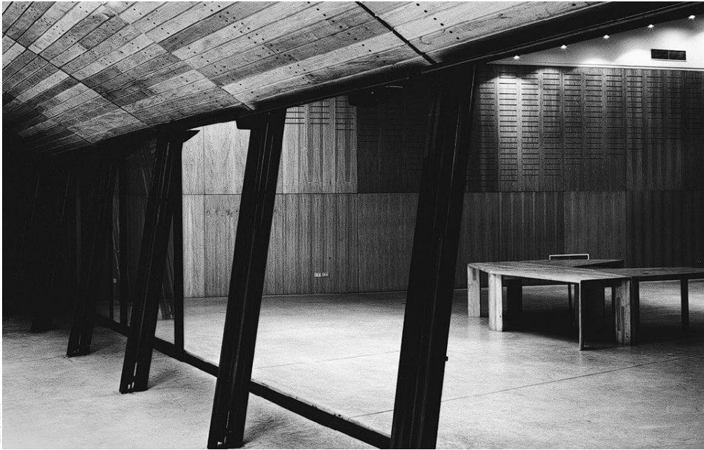
i binari per lo scorrimento della saracinesca in legno / the tracks for the sliding wooden blinds
