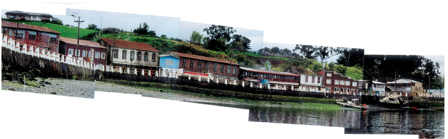
il porto di Chonchi, al centro l'edificio in costruzione / the port of Chonchi, at the center the building under construction
