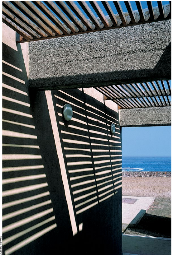
gli elementi frangisole dei percorsi pedonali / the sunscreens of the walkways
