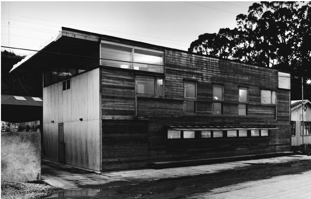
il fronte principale con gli elementi frangisole aperti / the main facade with the sunscreens open
